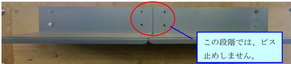
2. ジョイント部材が被さる位置にシール材を図のように塗布します。
