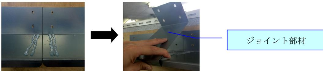
4. 小庇の取付け穴とジョイント部材の取付け穴が同じになるよう位置決めをし、ビスで共付固定します。
