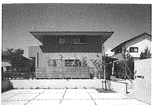
ガルバリウム雨とい スタンダード施工例 「那珂深の家」 (2007年竣工) 設計:伊礼智設計室 施工:自然と住まい研究所
